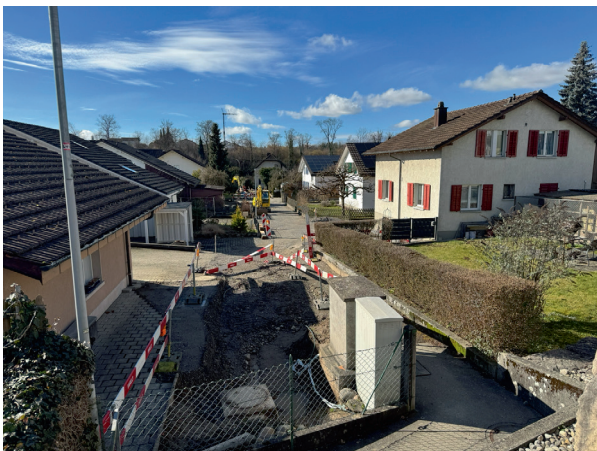
Werkleitungsanpassungen Friedmatt, Niederlenz
