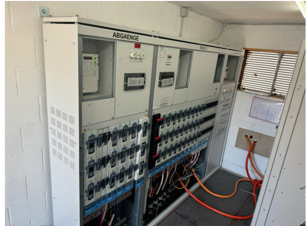
Neue Niederspannungsverteilung TS Festplatz
