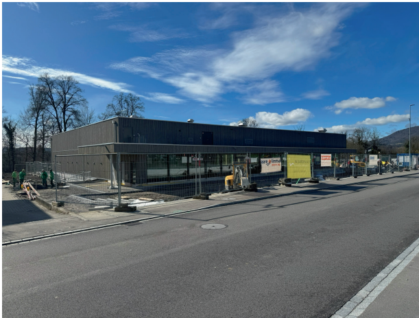
Neubau Dreifachturnhalle, Möriken
